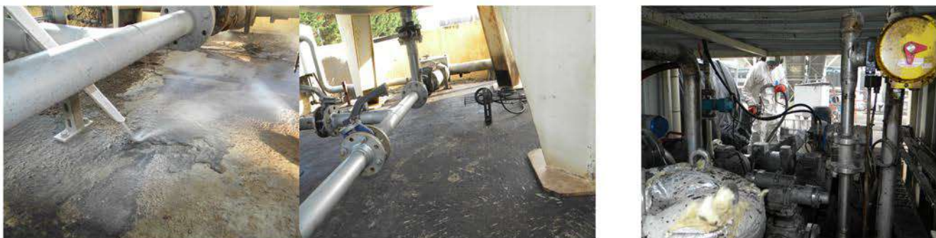
Nettoyage cryogénique d'un bac de rétention, d'un skid
